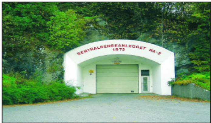
Sentralrenseanlegget RA-2 og Nedre Romerike vannverk kommer ikke inn under offentlighetsoven, fastslår styreleder Per Sandvik, og viser til at vann- og rensesanleggene ikke er forvaltningsorganer, men aksjeselskaper.
