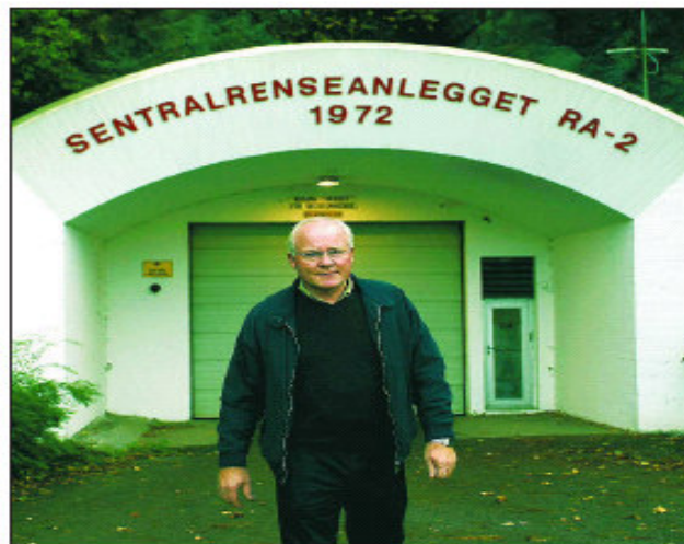
Per Erik Hveerem, som var prosjektleder for anleggsmøtet, varslet om at vannseksjonen RA-2 og administrerende direktørivar T. Hammes kjørte på vann og tjenester av selskaper som leverte rår og andre tjenester til de to vannseksjonene i selskapene. Låst ved valgde de å ikke ta dette opp på styremøtet.
