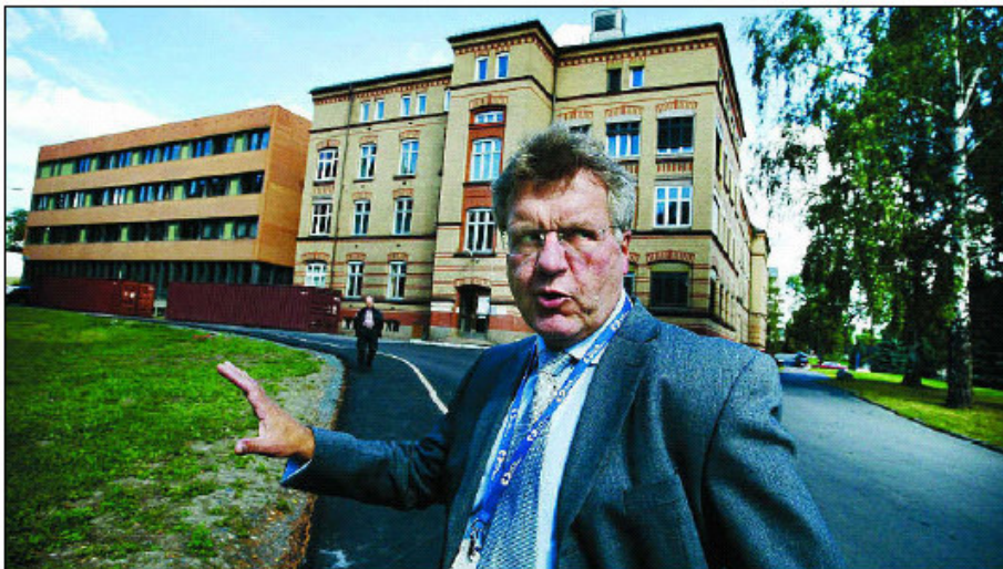
Tok affære. Direktør Helge Kjersem permitterte eiendomssjef Bjørn Haugseth med sykkeltur i går. Årsaken er at Haugseth har brutt reglene for anbud av offentlige anskaffelser og interne kontrollrutiner da han hyret inn en konkursrytter til flere byggeoppdrag ved sykehuset.
